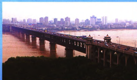
武汉长江大桥
