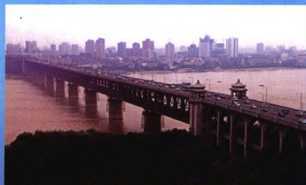
武汉长江大桥
