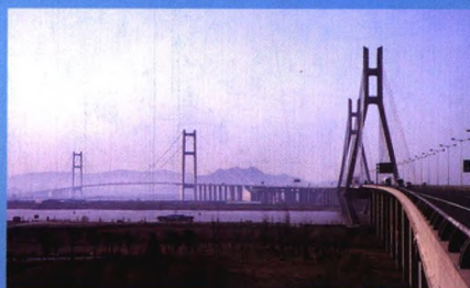
润扬长江公路大桥
