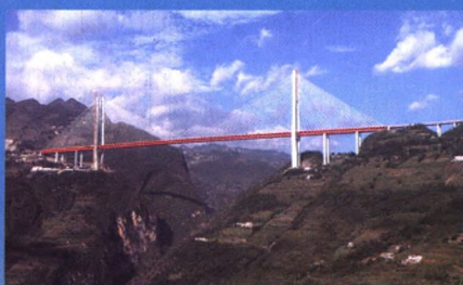
杭瑞高速北盘江大桥
