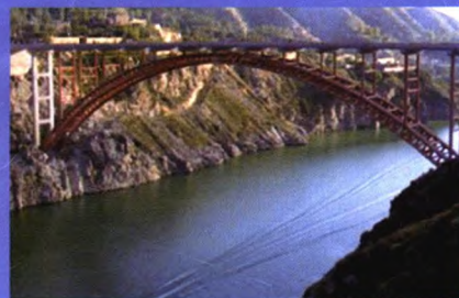
祁家黄河大桥
