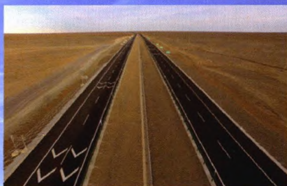
甘肃段白疙瘩至明水高速公路建设项目
