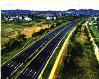
公路工程-顺蓬营一级公路
