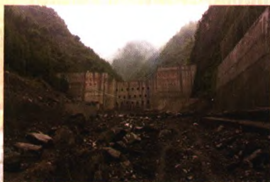
地灾治理-茶园沟支沟泥石流拦挡坝
