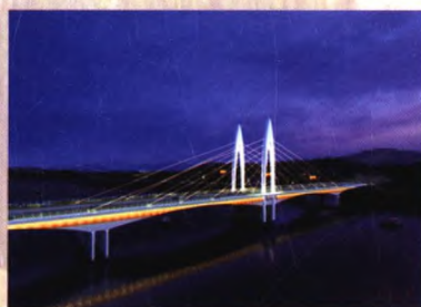
桥梁工程-致江路桥桥梁新建工程
