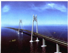
港珠澳大桥第三方试验检测
