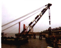
湛江石化项目桩基检测
