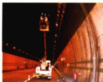
运营项目隧道健康检查
