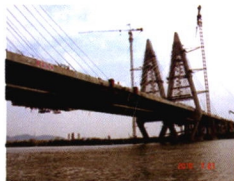
李家沙大桥检测
