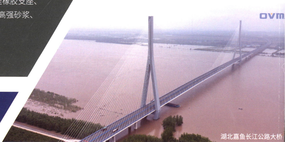
杨泗港长江大桥
