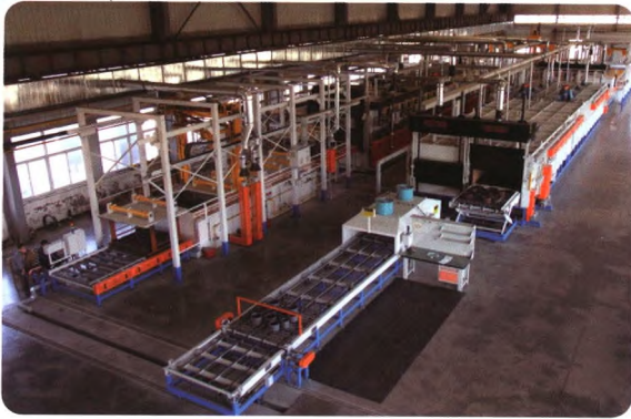
节能型辊棒炉盐浴淬火生产线
