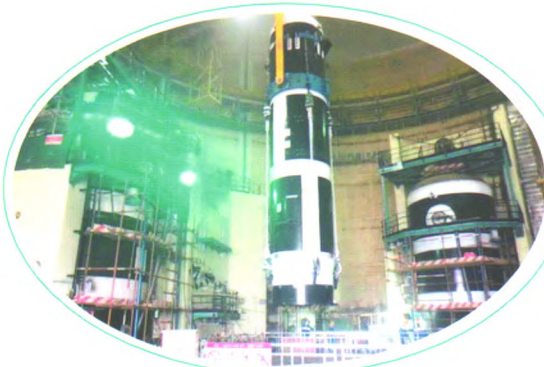
1号机组稳压器翻转就位
