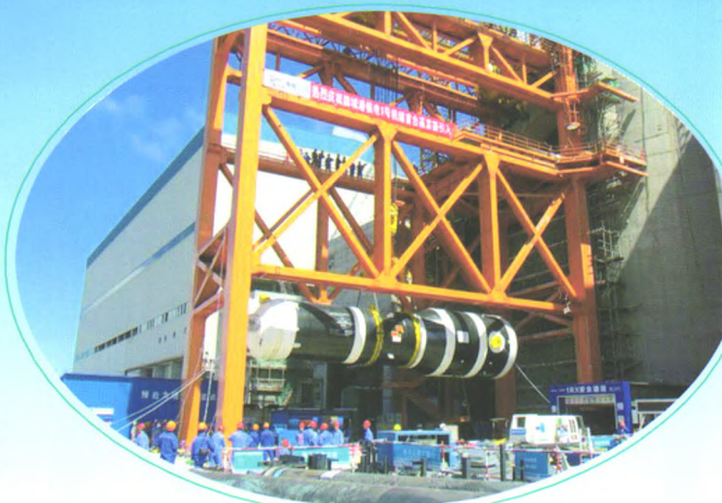
一号SG吊装引入
