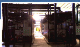
山东金诚重油化工有限公司 500t/h污水处理改造及回用项目
