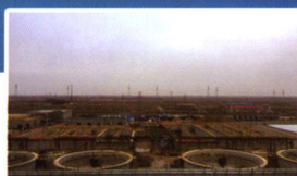
中海油东营石化升级改造及配套工程 污水处理场BT总承包项目
