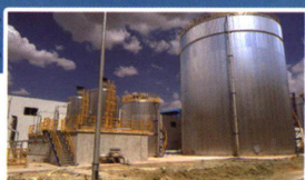
土耳其卡赞联合循环热电站 262t/h脱盐水站承包项目
