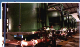
中海石油中捷石化有限公司 工艺水预处理EP项目
