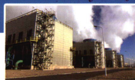
宁煤7.2万吨/小时工业循环 冷却水保运总承包项目
