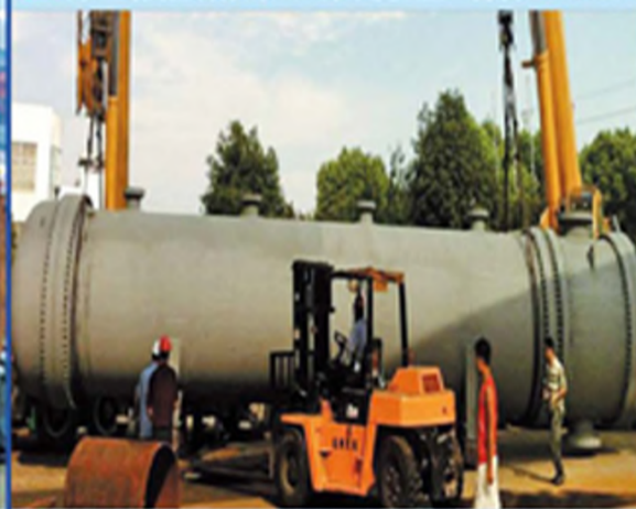
▲ 为福建联合制作的稀稀蒸汽再沸器 材质: Q345R
