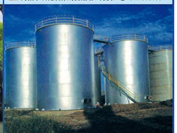
▲ 为韩国公司现场制作的大型贮罐 材质: S30408
