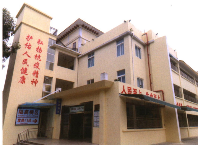
三亚中心医院（海南省第三人民医院）隔离病区图
