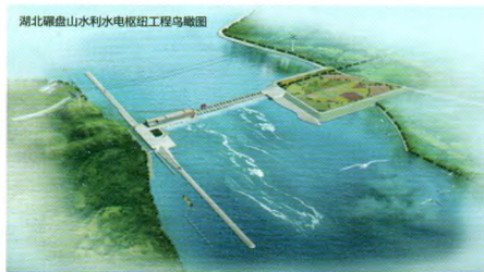
碾盘山水利水电枢纽工程鸟瞰图
