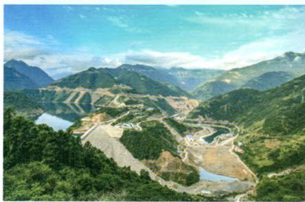
龙背湾水电站坝址
