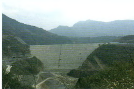
龙背湾水电站混凝土面板堆石坝
