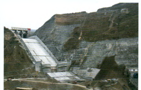
龙背湾水电站溢洪道泄槽
