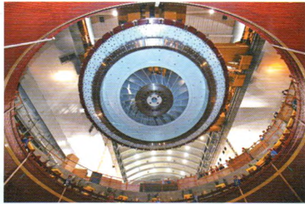
溪洛渡转子吊装
