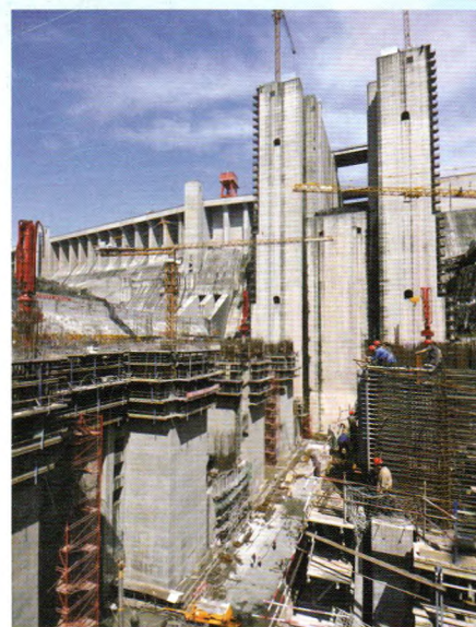
三峡升船机工程施工
