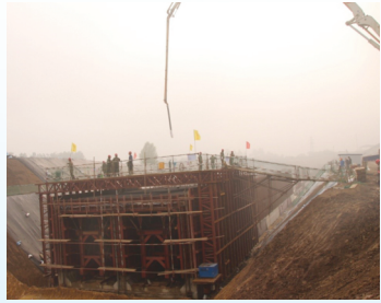
鄂北13标首仓暗涵混凝土浇筑完成
