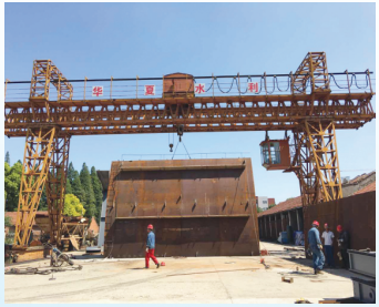
金结公司进行蒙江沅各水电站弧形闸门预拼装
