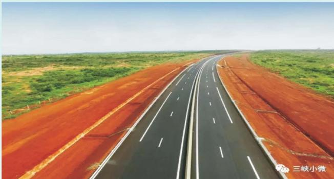
三峡集团中水电对外公司塞内加尔AMT（布莱斯迪亚涅国际机场-姆布尔-捷斯）收费高速公路项目全长约62.9 km（含7 km机场连接线），为全封闭双向四车道，采用沥青混凝土路面结构，设计时速130 km/h。该项目建成后将实现首都达喀尔、迪亚涅新机场、姆布尔以及圣城图巴的高速公路互通，显著改善新机场对外交通体系，保障水泥出口需要及促进当地旅游业发展，同时本项目为当地提供1 600人直接就业和4 000人间接就业。
