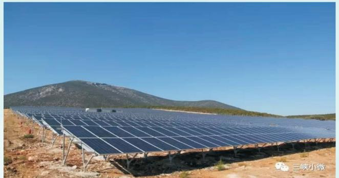
希腊光伏示范项目是三峡集团在海外投资建成的第一个光伏项目。项目总装机容量18 MW，年均发电量2 258.28万kW·h，由四个子项目组成。其中希腊西南部有两个子项目，装机容量均为2 MW，年均发电量分别为250.92万kW·h；希腊中马其顿大区有两个子项目，装机容量均为7 MW，年均发电量分别为878.22万kW·h。
