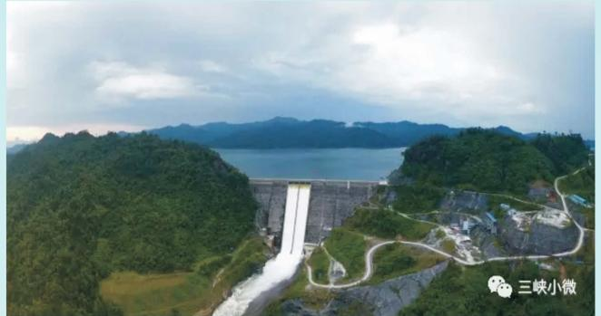
沐若水电站位于马来西亚东马的婆罗洲岛的砂捞越州，坝址位于拉让（Rajang）河流域源头沐若河上，工程由碾压混凝土重力坝、导流洞、引水发电系统等建筑物组成，装机容量为94.4万kW，工程于2008年10月1日开工，2015年4月竣工。沐若水电站项目是三峡集团以EPC方式总承包建设的第一个海外项目。
