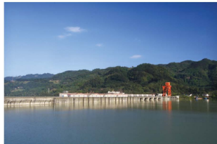
铜街子水电站大坝水库全景
