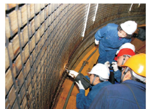
机组定子 电腐蚀诊断处理
