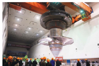
铜街子水电站 12号机组转轮体“三体联吊”
