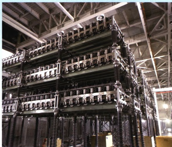
世界上电压等级最高、容量最大的500千伏统一潮流控制器平台
