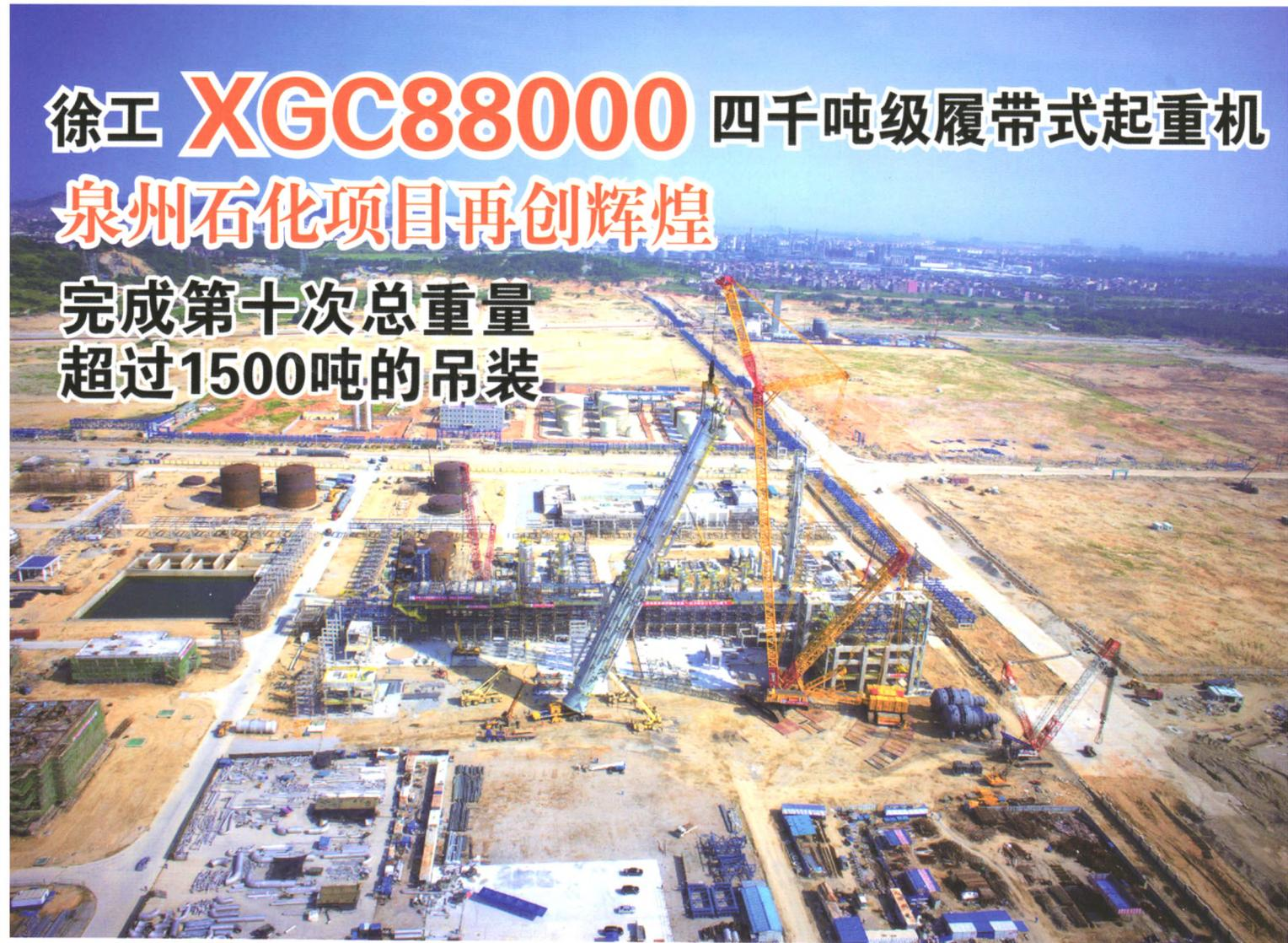
徐工 XGC88000 与石化罐体安装专用溜尾机 XGW1100 相配合，采用 102 米重型主臂，33 米固定副臂工况，将直径 6.9 米，高 105.7 米，吊装总重量达 1750 吨的洗涤塔吊装到位，产品的高可靠性和高安全性得到最完美的诠释。
