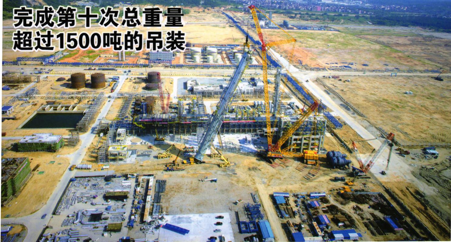
徐工 XGC88000 与石化罐体安装专用溜尾机 XGW1100 相配合，采用 102 米重型主臂，33 米固定副臂工况，将直径 6.9 米，高 105.7 米，吊装总重量达 1750 吨的洗涤塔吊装到位，产品的高可靠性和高安全性得到最完美的诠释。
