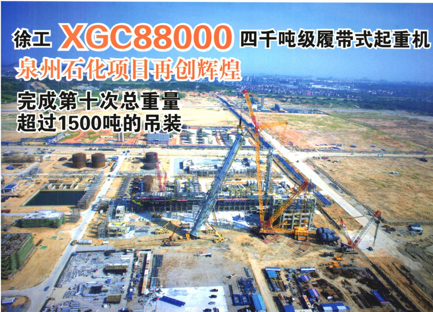
徐工 XGC88000 与石化罐体安装专用溜尾机 XGW1100 相配合，采用 102 米重型主臂，33 米固定副臂工况，将直径 6.9 米，高 105.7 米，吊装总重量达 1750 吨的洗涤塔吊装到位，产品的高可靠性和高安全性得到最完美的诠释。
