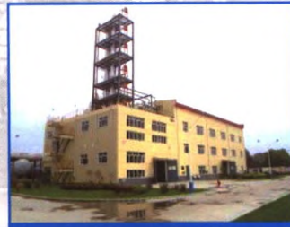
异戊橡胶中试装置
