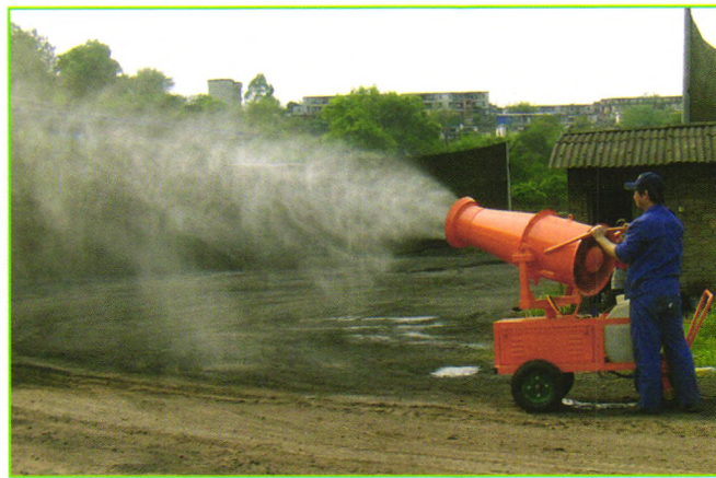
手推式环保除尘喷雾装置（小范围的喷雾降尘）
