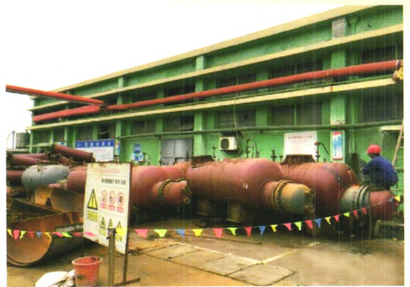
拆除首条HCFCs生产线现场
