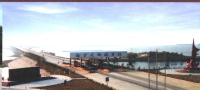
白沙大桥收费站
