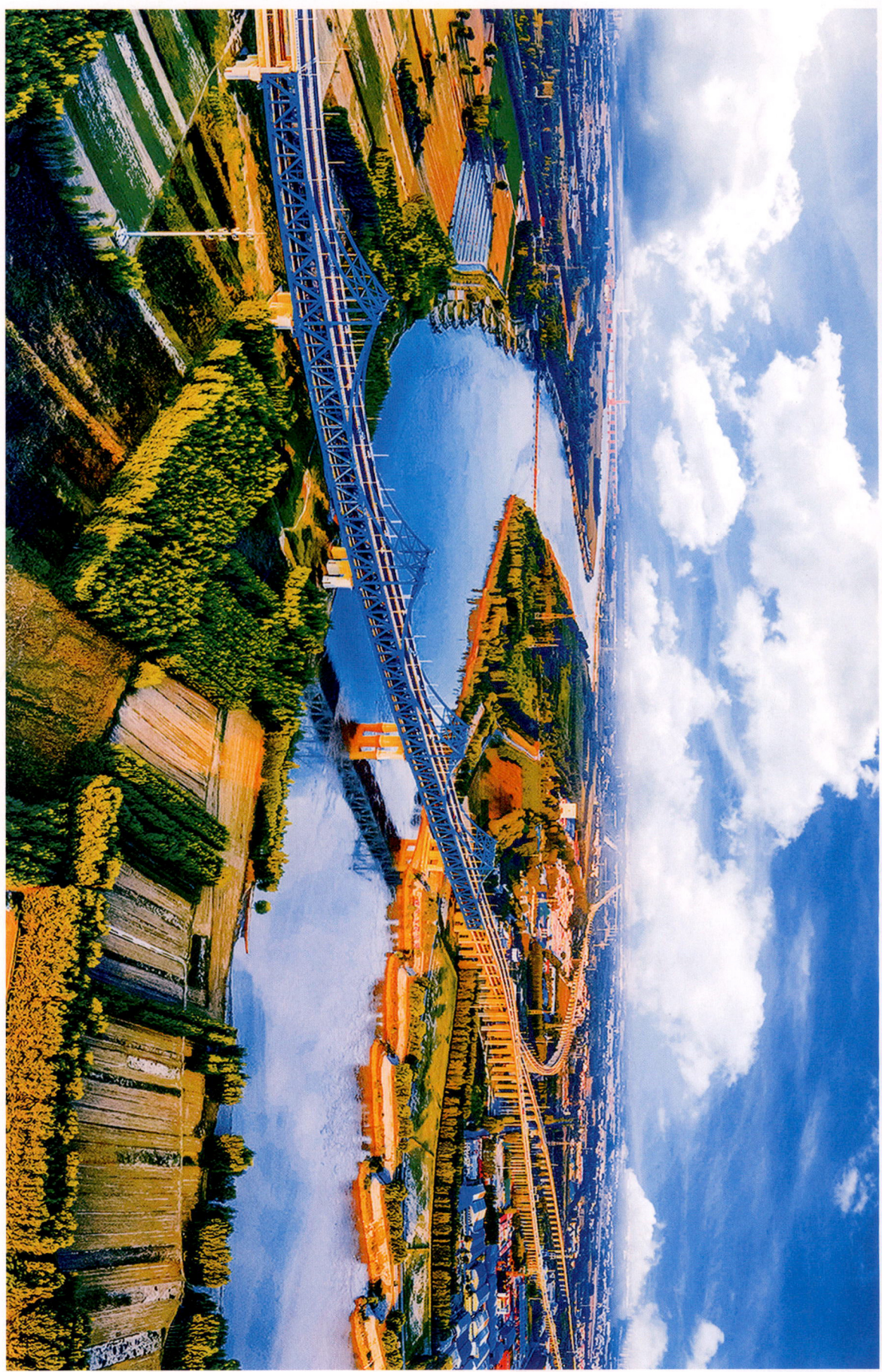
图为连通济南起步区与济南市区的济乐高速黄河公铁两用特大桥。
