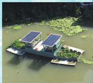
乌篷式一体化 应急处理净化槽系统 奉贤区黑臭河道治理工程
