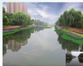
生态浮床改良技术 污染水体治理工程
