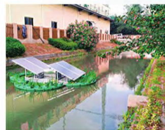
太阳能曝气增氧技术 污染水体治理工程
