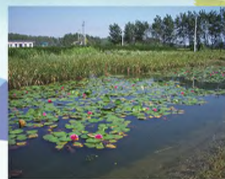
微曝气垂直高负荷 人工湿地技术 无锡第三污水厂尾水净化工程
