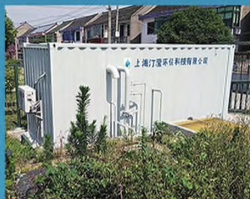
A/O-MBR技术 奉贤盛家港 农村生活污水治理工程
