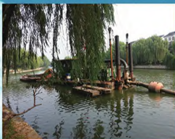
底泥环保疏浚技术 徐汇区河道污染污泥清淤技术 课题试验工程
