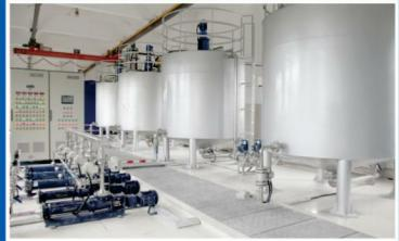
**高锰酸钾\聚丙烯酰胺投加系统**是一种将高锰酸钾/聚丙烯酰胺固体颗粒与水按一定浓度配制后、精确投加至水中的全自动成套投加设备。其主要工作流程为吸料机吸料、密闭料仓储存,精确给料机给料、不锈钢溶解罐溶解配置,计量泵投加,自控柜控制,精确投加至投加点,以达到净化水质的目的。
