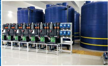
**石灰\活性炭投加系统**是一种将粉末与水按一定比例配制后、精确投加至水中的全自动成套投加设备。其主要工作流程为密闭料仓储存,精确给料机给料、螺旋输送机输送,不锈钢溶解罐溶解配制,螺杆泵投加,自控柜控制,精确投加至投加点,以达到水质处理的目的。
