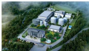
三明市区餐厨垃圾项目
