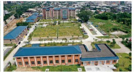
福州市飞凤山水厂工程 省优秀工程勘察设计成果水系统专业一等奖
