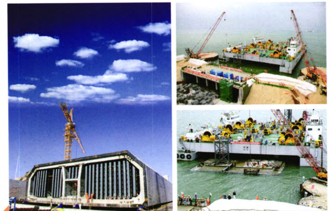
P61 超级沉管海底对接 ——盘港珠澳大桥超级工程设备(第二集)
