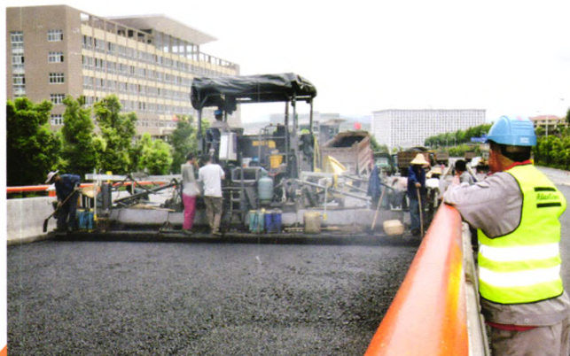
P46 戴纳派克F3030摊铺机助力昆明南连接线工程
