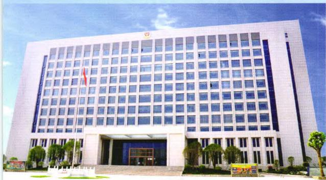
武警河南省总队指挥中心，位于郑州市熊耳河路与东风东路交叉口西南角，建筑层数地下二层，地上十二层，建筑高度53.60m<sup>2</sup>；总建筑面积34471.44m<sup>2</sup>，其中地下建筑面积10425 m<sup>2</sup>，地上24046 m<sup>2</sup>（人防建筑面积6585 m<sup>2</sup>）。抗震设防烈度为七度，建筑防水类别及耐火等级为一类高层，地上部分耐火等级为一级，地下耐火等级为一级。本工程地下一层为人防地下室，平时为汽车库，战时为常6级和核6级防护，甲类二等人员掩蔽部。
