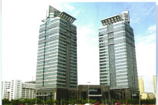
赣州市市政中心北区主楼工程，位于赣州市长征大道市政中心北区，该工程由赣州市建筑设计院设计，江西金洪建设监理有限公司监理。基础为人工挖孔混凝土（扩底）灌注桩桩基。框架核心筒结构，加气混凝土砌块填充墙。外墙主体四层以上3mm厚铝单板、6+9A+6双层中空隐框玻璃幕墙装饰，裙楼、主楼一至三层外墙石材干挂，+9A+6双层中空隐框玻璃幕墙。工程总建筑面积为67076平方米，其中地上建筑面积为60063平方米，地下室建筑面积为7013平方米。建筑层数为地上27层，地下一层，裙楼三层，建筑总高度主楼102.90米，裙楼13.6米。
