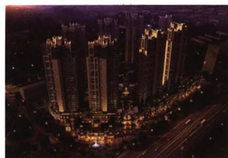
晋和天庆花园一期： 广东省优 位于珠海市金湾区金海岸大道南侧 总建筑面积为94579.66平方米，建筑高度95.6米
