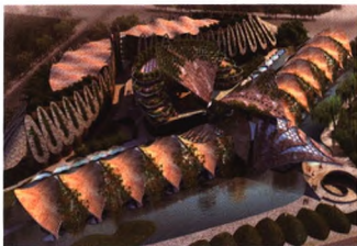
玛丝菲尔二期： 中国钢结构金奖 位于深圳市宝安区大浪服装产业基地 总建筑面积68788平方米。
