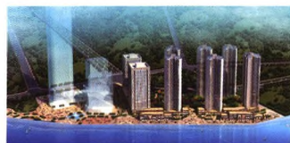
恒大外滩首期6#楼及地下室： 海南省“绿岛杯” 位于海口市滨海大道北侧新港片区 总建筑面积154129.16平方米，建筑高度133米。
