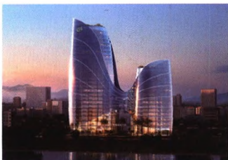
华策国际大厦钢结构工程： 中国钢结构金奖 位于珠海市横琴区 总建筑面积112461.05平方米，塔楼最大高度为26层， 最高点高度133米。
