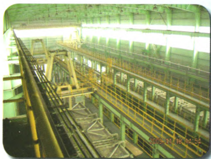
隧道式碳钢盘条酸洗线
