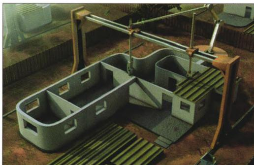
—— “轮廓工艺” 其实就是一个超级打印机器人, 工作速度非常快, 24 h 之内能打印出一栋两层楼高、约合 232 平方米的房子。它不仅负责打印外墙, 铺地板、水管、电线, 甚至连上漆、贴墙纸也一手包办, 但它并不能完全取代工人, 住宅建筑的许多部分, 诸如水电、供热管道、门窗和吊顶等仍需要借助工人手工完成安装。它可以在灾区重建、贫民区改造中大显身手。由于成本低廉, 过几年换一套也完全可行……
