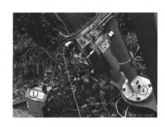
摘要: 500 m 口径球面射地望远镜(Five-hundred-meter aperture spherical radio telescope, FAST)促动器液压系没有过滤设计,随着运行时间的增长,设备的油液清洁度等级普遍超过设计许用范围,对其可靠性和使用寿命构成严重影响。针对该问题,提出液压系统动态平衡过滤概念,建立促动器液压系统污染控制数学模型,结合促动器现有条件设计了外挂式过滤系统方案。Matlab 软件仿真显示,安装外挂式过滤系统后,液压促动器经 10 次工作循环达到动态平衡,油液清洁度等级为 NAS6 级。样机试验表明,理论和试验结果一致性较好,验证了污染控制模型建立的准确性和外挂式过滤系统方案的有效性。通过理论分析与试验相结合的方法,为FAST 液压促动器油液污染问题处理提供了一种有效的外挂式过滤系统解决方案,也为类似液压系统油液污染控制研究提供参考。
