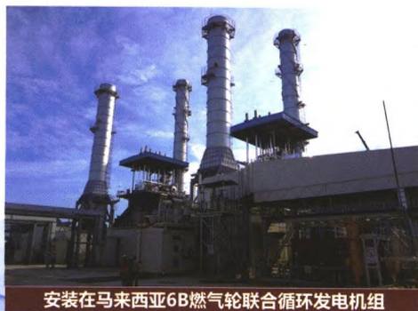
安装在马来西亚6B燃气轮联合循环发电机组
