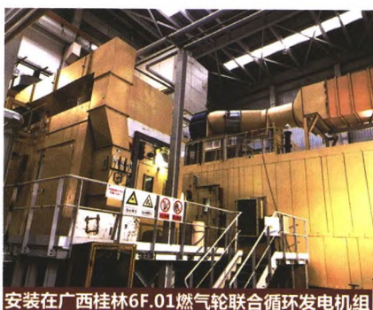
安装在广西桂林6F.01燃气轮联合循环发电机组
