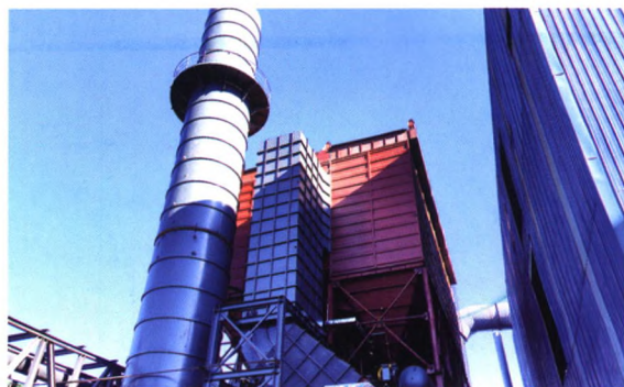
■ 山西兴华精炼炉除尘器---建设中
