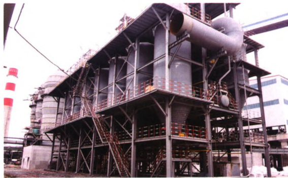
■ 营口3号高炉煤气除尘系统---建设中
