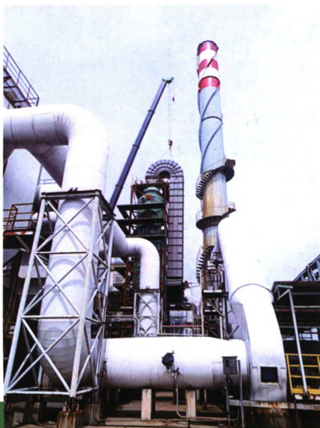
■ 广西梧州金升铜业脱硫系统---建设中
