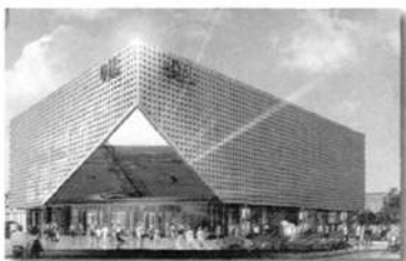
上海世博会-石油馆
