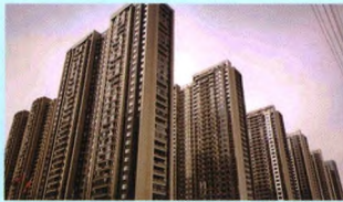
项目名称:郑州万科城七期(C31-01)地块项目 承建单位:重庆万泰建设(集团)有限公司 重庆建工脚手架有限公司
