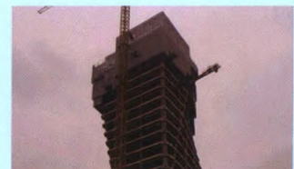
项目名称:太阳座工程项目 承建单位:重庆建工脚手架有限公司
