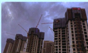
项目名称:2018J P02地块工程项目(天境云著项目) 承建单位:厦门安科科技有限公司
