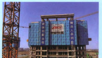
项目名称:恒大未来之光花园 承建单位:中铁十二局集团建筑安装工程有限公司 原平构件分公司
