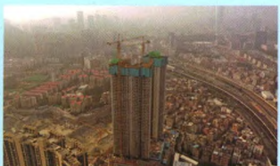
项目名称:罗湖“二线插花地”棚户区改造项目(施工总承包1标木棉岭片区01-02地块主体工程) 承建单位:深圳市特辰科技股份有限公司
