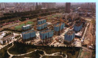
项目名称:福州万科澜悦花园(二区) 承建单位:广东奇正模架科技有限公司
