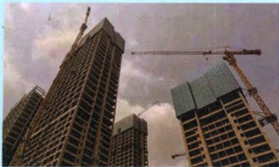
项目名称:横琴万象世界项目(二期)主体工程-1标段 承建单位:中国建筑第五工程局有限公司 广州达蒙安防科技有限公司
