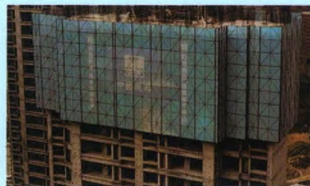
项目名称:许昌保利堂悦花园项目 承建单位:中国建筑第五工程局有限公司 深圳市特辰科技股份有限公司
