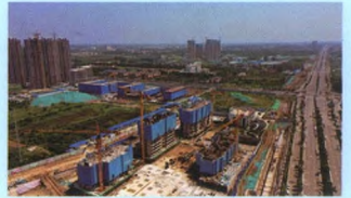
项目名称:昌建五悦里观璟项目 承建单位:河南昌浩建筑装饰工程有限公司 河南祥中工程建设有限公司
