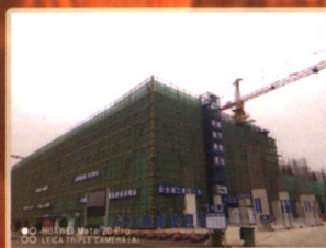
建设单位:湖南五恒模架股份有限公司 工程名称:佛山林岳车辆段项目 类别:承插型盘扣式钢管脚手架
