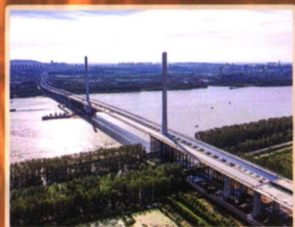
建设单位:安徽卓良新材料有限公司 中交第二公路工程局有限公司 工程名称:浦仪公路西段A2标项目 类别:承插型盘扣式钢管脚手架
