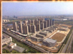
建设单位:北京中铁建建筑科技有限公司 工程名称:南昌书香瑶庭项目 类别:铝合金模板
