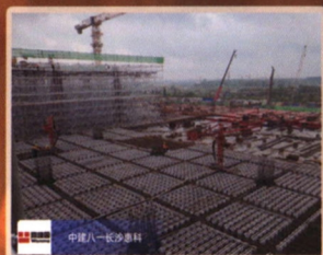
建设单位:天津鼎维固模架工程股份有限公司 工程名称:长沙惠科第8.6代超高清新型显示器件生产线项目主厂房项目 类别:承插型盘扣式钢管脚手架
