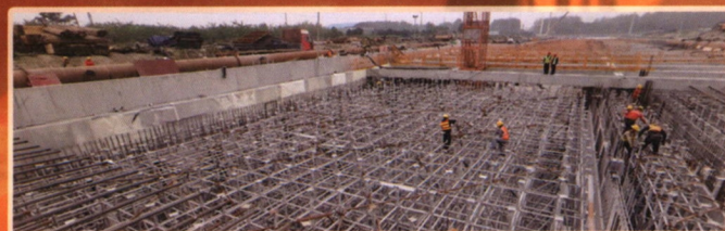
建设单位:中交第二航务工程局有限公司 武汉航科物流有限公司 工程名称:襄阳市东西轴线道路工程鱼梁洲段项目 类别:承插型盘扣式钢管脚手架
