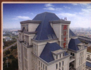
建设单位:山东天元工程科技有限公司 工程名称:临沂大学——科技大楼项目 类别:扣件式钢管脚手架
