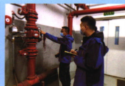
安全隐患专项检查
