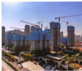
株洲建发央著一期项目
