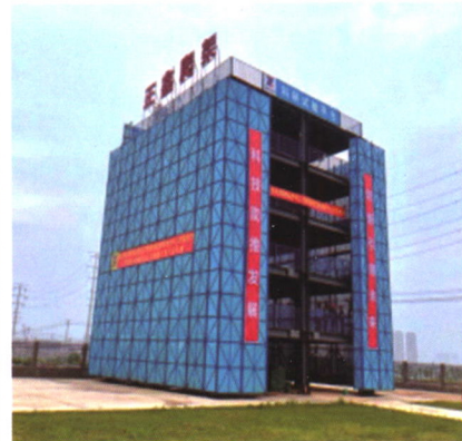
附着式升降脚手架(CD13-C型)
