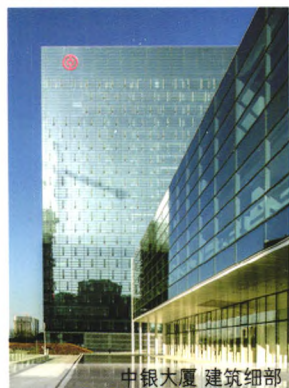
中银大厦 建筑细部
