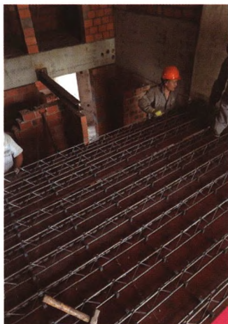
LOFT 夹层楼承板安装中
