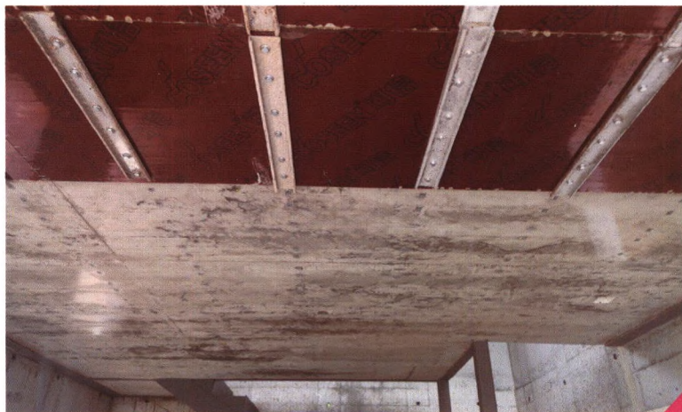
LOFT 夹层楼承板底模拆除后
