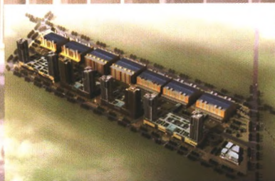
成都银犁物流冷链二期B4/B5冷库
