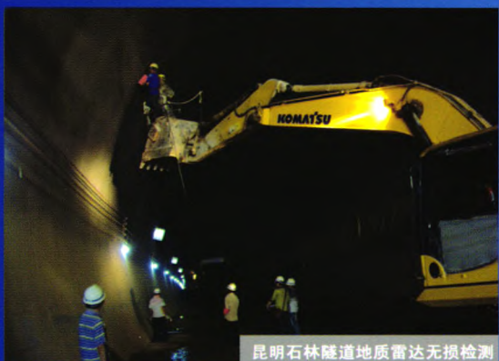
昆明石林隧道地质雷达无损检测
