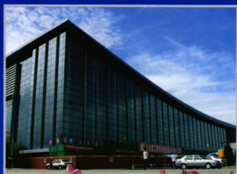
国家会议中心 大跨度预应力梁/预应力超长结构/预应力抗浮桩
