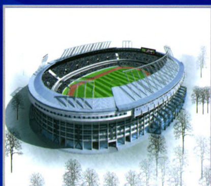
工人体育场改造和灯架悬索结构
