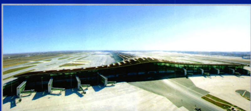
首都机场3号航站楼 大跨度预应力梁/预应力超长结构
