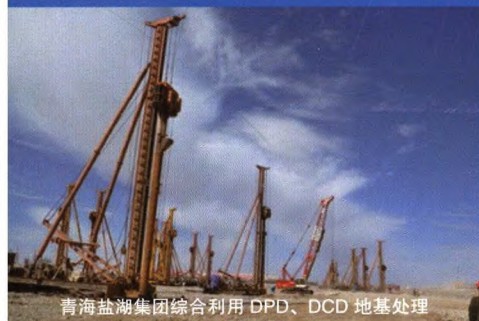
青海盐湖集团综合利用 DPD、DCD 地基处理
