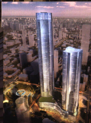
昆明春之眼商业中心项目主、桩基工程钻芯检测与咨询合
