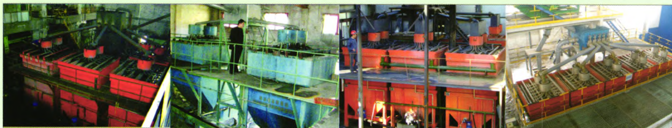
唐钢庙沟铁矿应用现场
