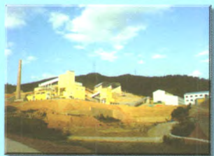
云南40万吨褐铁矿磁化焙烧工程现场
