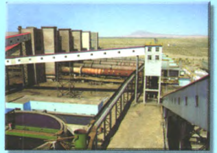
200万吨褐铁矿磁化焙烧工程施工现场
