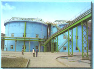
酒钢选矿厂2套φ25米高效浓缩、工程控制及输送建设承包工程
