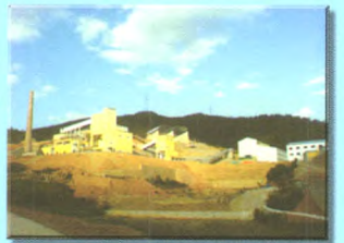
云南40万吨褐铁矿磁化焙烧工程现场
