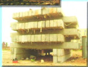
华能电厂高应变现场、静载现场
