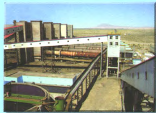
200万吨褐铁矿磁化焙烧工程施工现场
