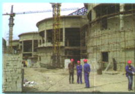
酒钢400万吨新选厂浓密机建设现场
